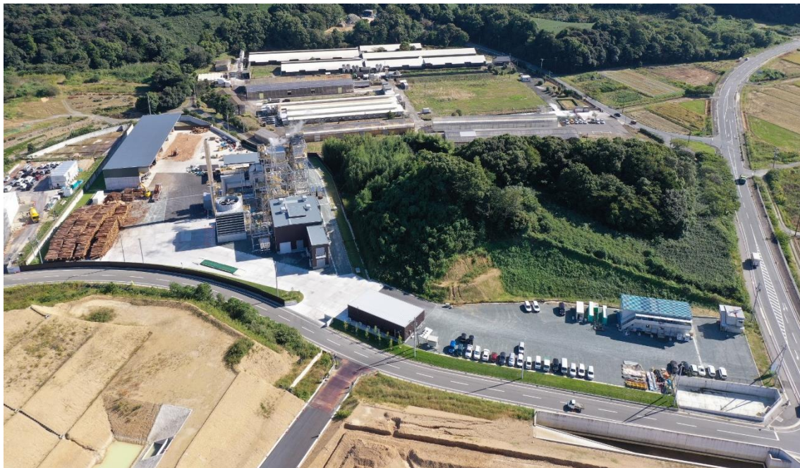
(本発電所の全景)
