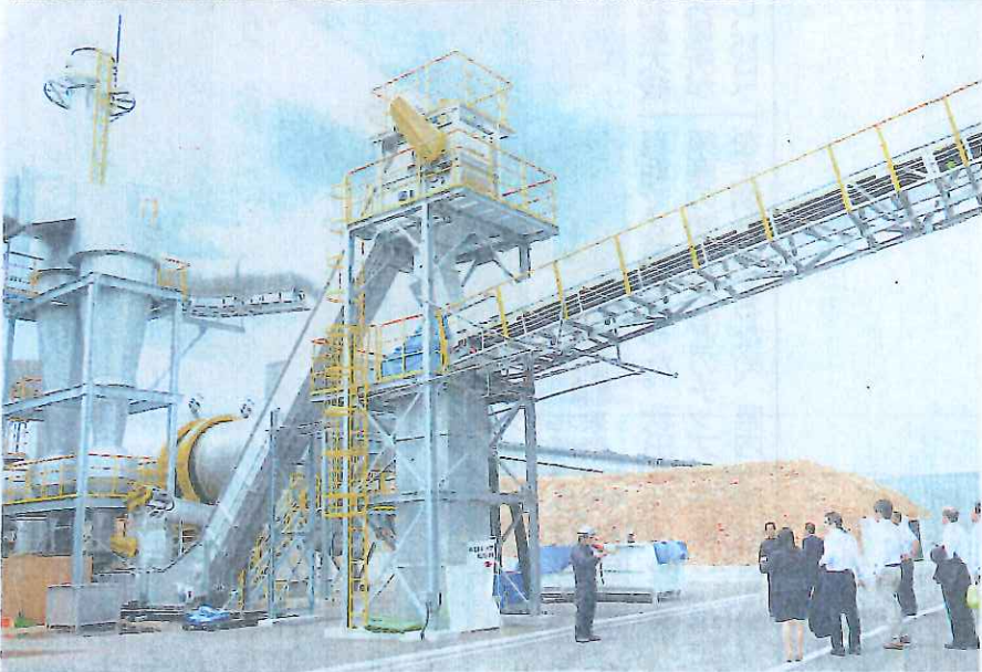
現地では木質チップ乾燥設備(左)などを巡る見学会も開かれた
