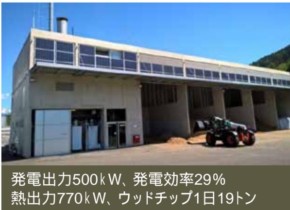
発電出力500kW、発電効率29%
